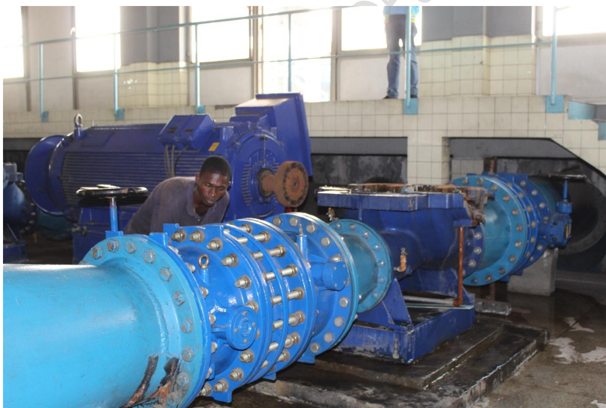
Aperçu de l'atelier de montage de Groupe Motopompe/Kinshasa
