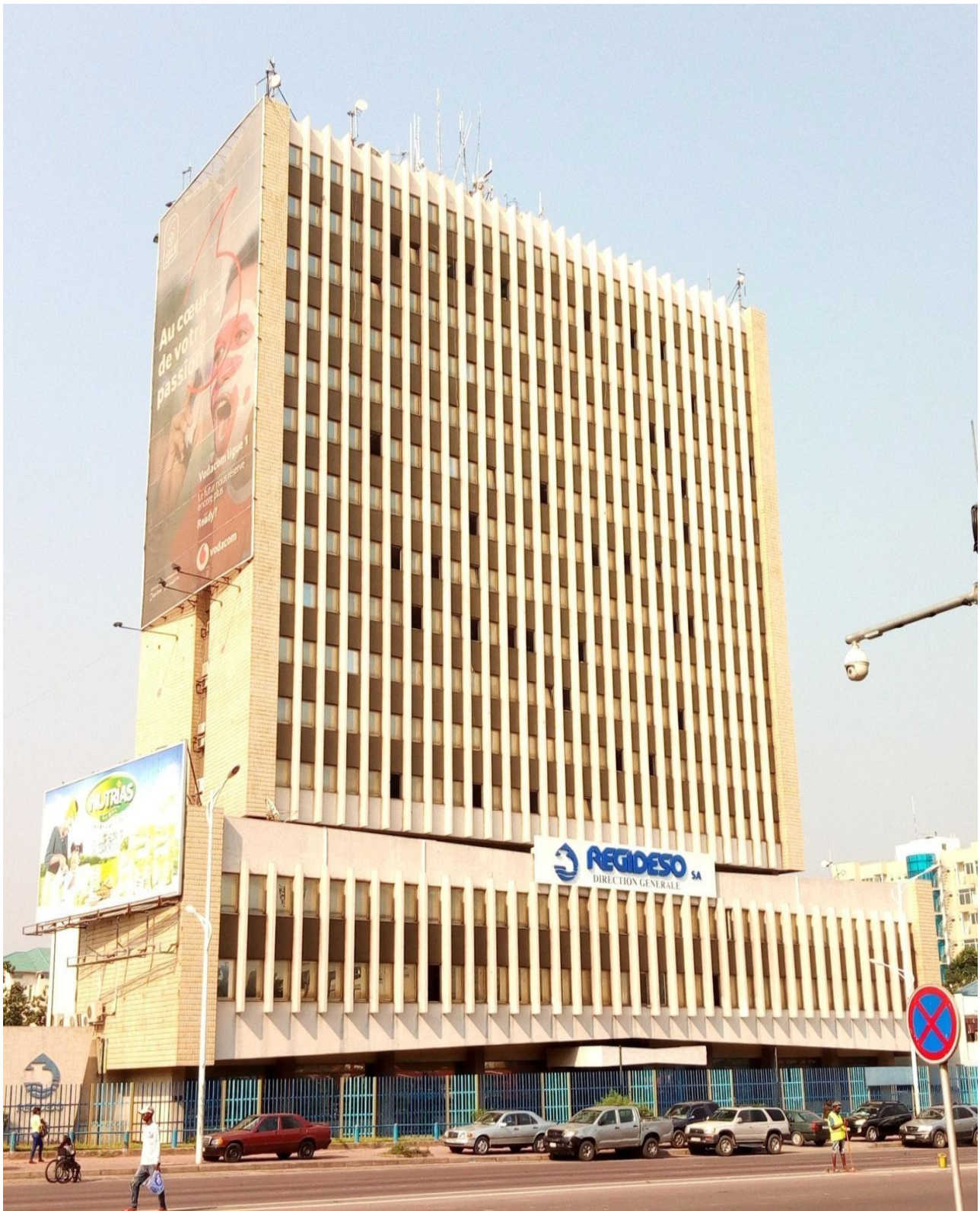
Bâtiment administratif de la DG/REGIDESO SA, Kinshasa.
