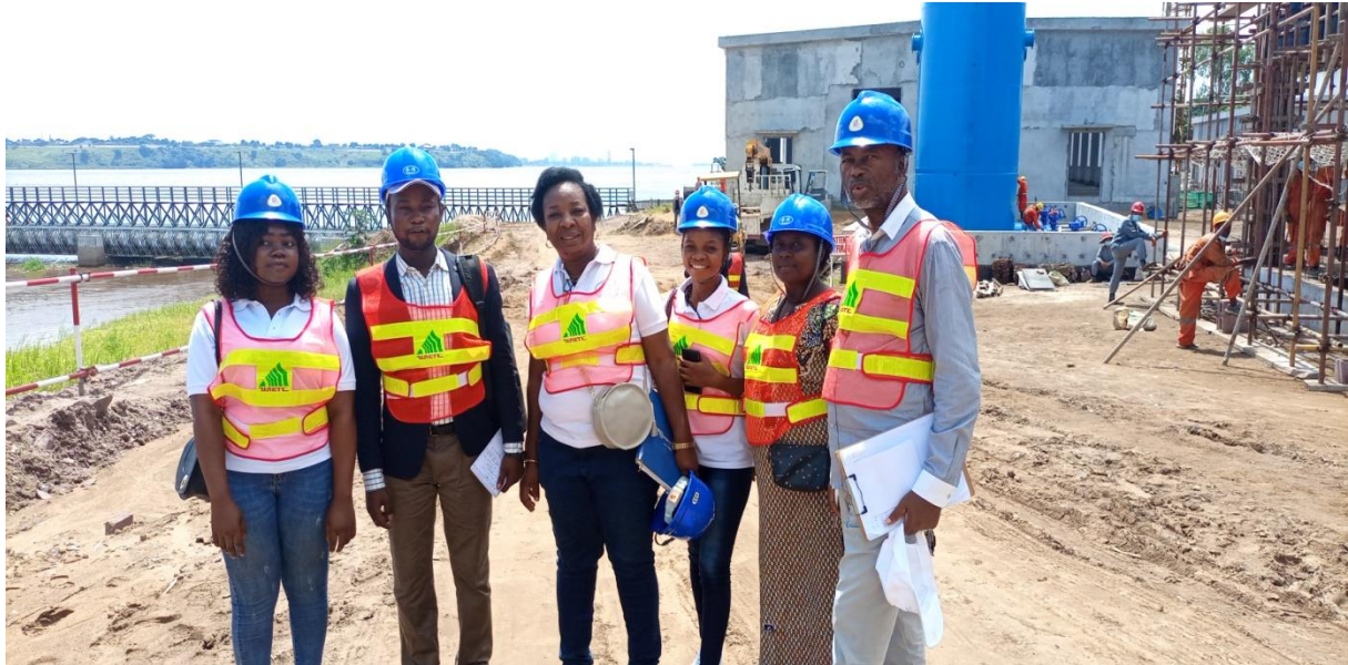
Visite du point de captage d'eau brute de la nouvelle Usine de l'Ozone
